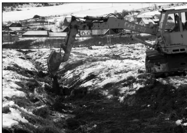
Prace nad rewitalizacją uregulowanego cieku
